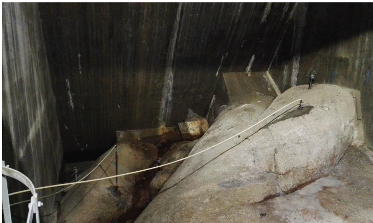
Foto av dränage och installerade portrycksmätare (Foto: Diego Alcalá Perales).
